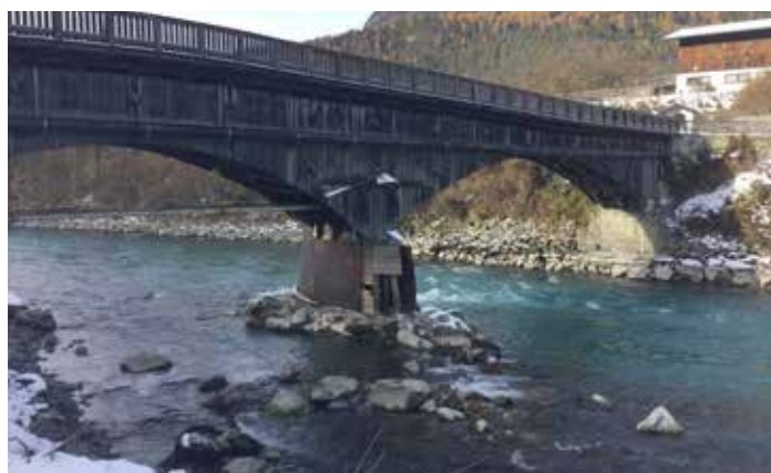
Die über 100 Jahre alte Holzbrücke wird komplett erneuert.
