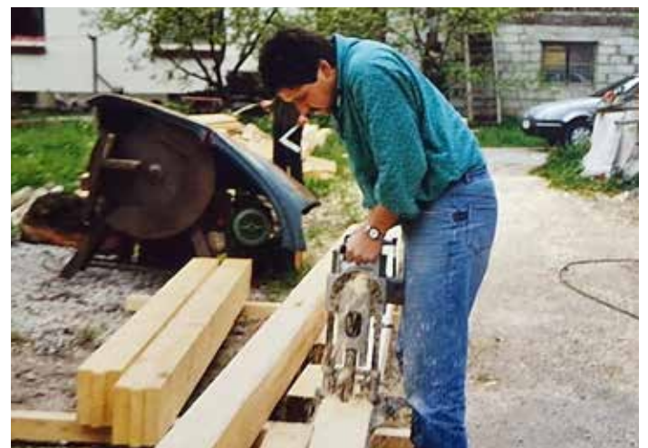
Ein neues Clubhaus entsteht.
