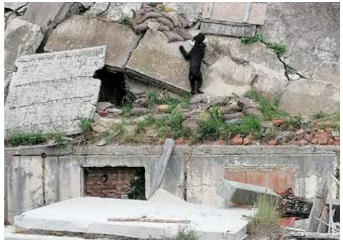
Auch Riesenschnauzer Ilai hat an der abgerissenen Hausfassade bei Haus 1 die Witterung aufgenommen und arbeitet sich zur Versteckperson vor, welche in den Trümmern mit seiner Belohnung wartet.
