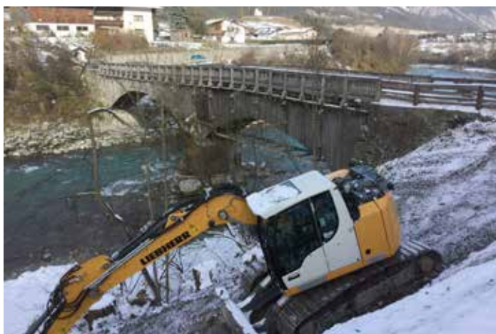
Die Arbeiten für die Behelfsbrücke sind bereits angelaufen.
