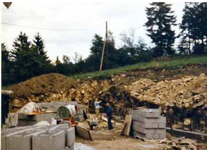
Bahnenbau hinterm Waldelerhof.
