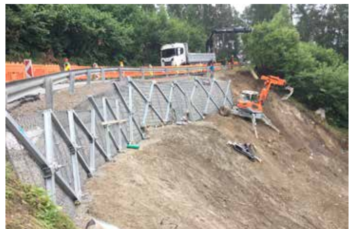
Sicherungsarbeiten der Firma Geos Spezialbau.
