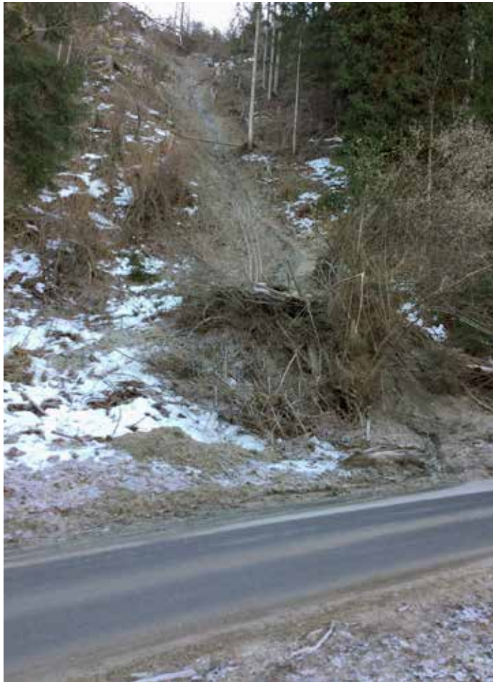
Wegen Erdrutschen musste die Dorfstraße zwischen Waldele und Hohenegg im Spätherbst teilweise gesperrt werden.
