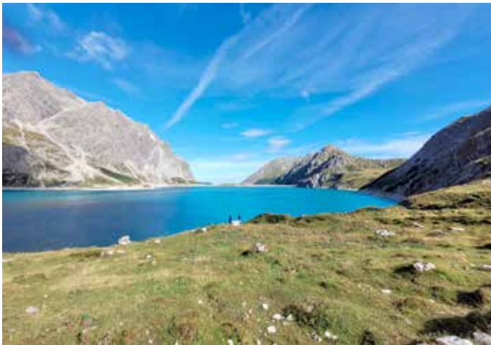
Blick zur Staumauer des Lünersees.
