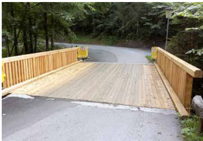
Die neue Brücke zwischen „Mühle“ und „Waldele“.
