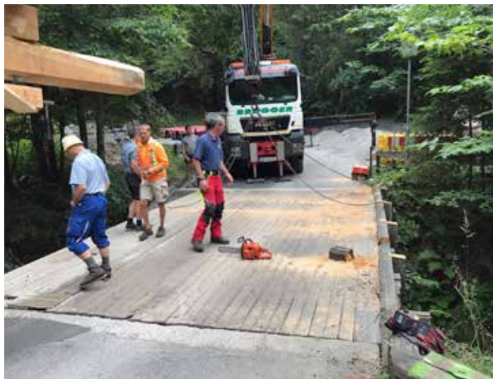
Abbrucharbeiten der Waldelerbachbrücke.
