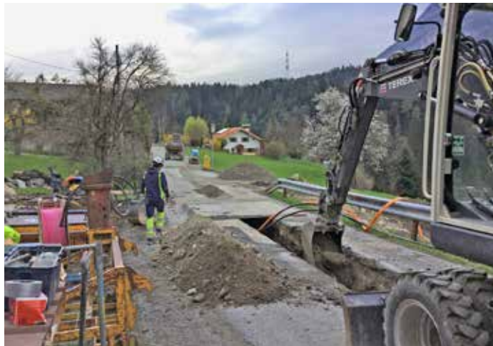
Der Weiler „Mühle“ wurde an das öffentliche Wasserversorgungsnetz angeschlossen.
