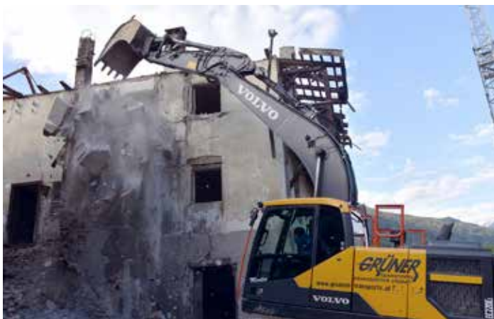
Stück für Stück wurde das Bock-Haus abgetragen.
