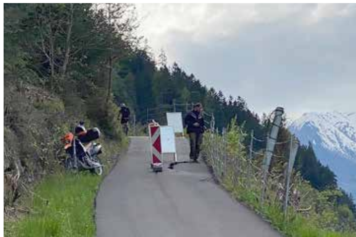
Nach zwei Wochen fachgerechter Renovierung konnte der Radweg wieder freigegeben werden.
