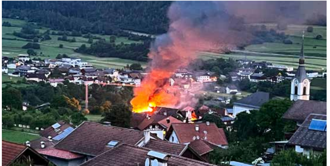
Der Dachstuhl stand in Vollbrand und drohte auf die angrenzenden Gebäude überzugreifen.
