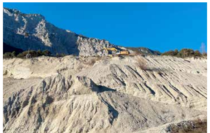
Der Hang wird ressourcenschonend abgetragen.
