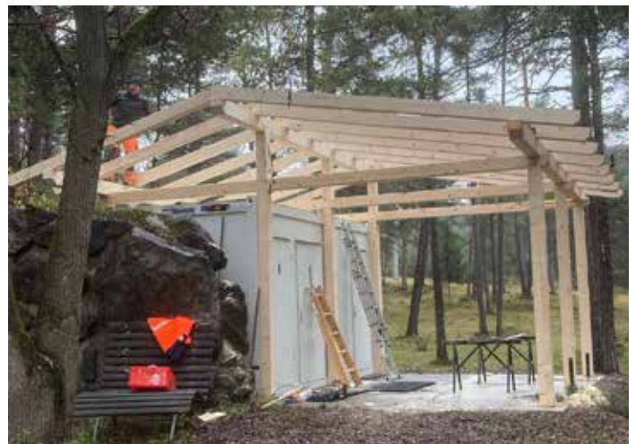
Die WC-Anlage wurde großzügig umgebaut.
