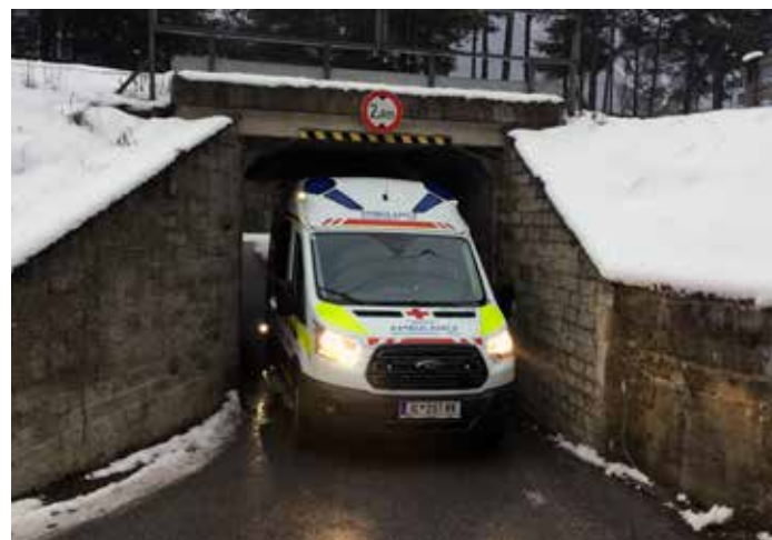
Rettings-Einsatzfahrzeug in der bestehenden Riedegg Unterführung – eine sehr knappe Sache.
