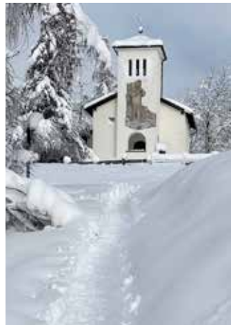
Am Burschl stehen heuer einige Renovierungsarbeiten an.
