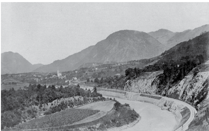
Bahnbau mit Blick nach Roppen. Mit dem Bau der Arlbergbahn wurde 1880 begonnen. Nachdem zwischen Innsbruck und Landeck der Verkehr am 1. Juli 1883 aufgenommen wurde, erfolgte die Freigabe der gesamten Strecke am 21. September 1884.
