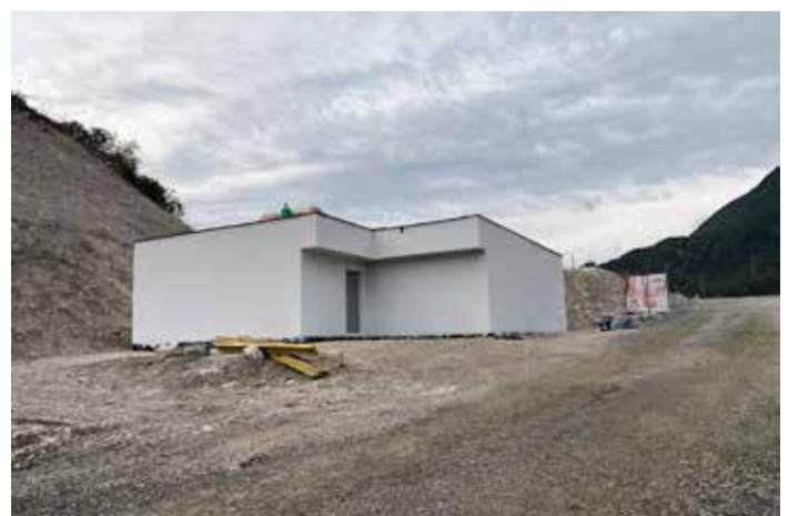
Der neue Löschwasserbehälter im Gewerbepark Roppen
