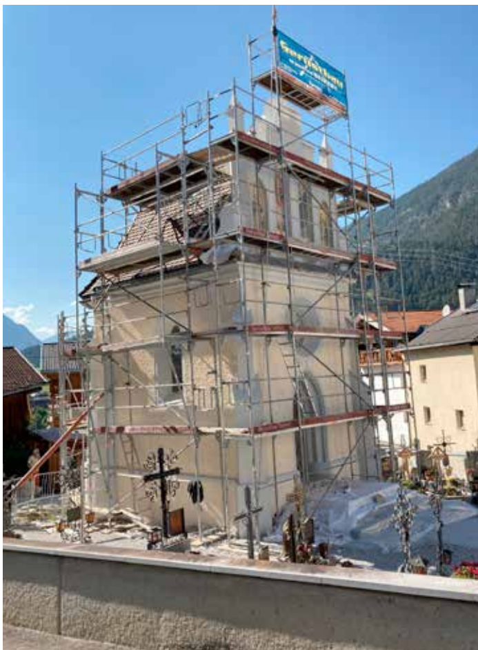
Die Lourdeskapelle wurde in den Originalfarben renoviert.
