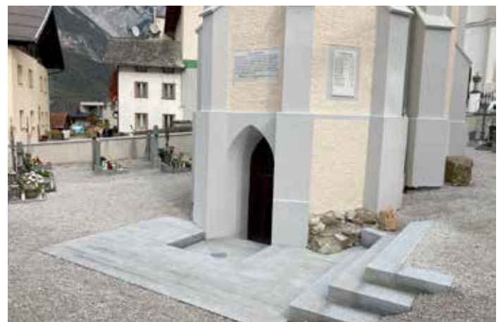
Auch im unteren Bereich ist der Eingang nun einladend.
