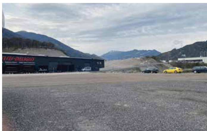
Der nordöstliche Teil der dritten Baustufe wurde bereits voll erschlossen und die Zufahrtsstraße asphaltiert.
