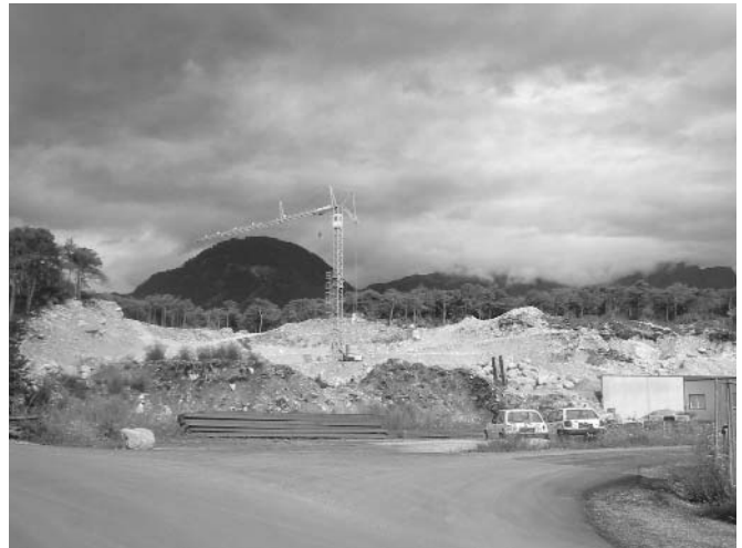
Endlich Baubeginn für die neuen Betriebsgebäude Foto: WR
