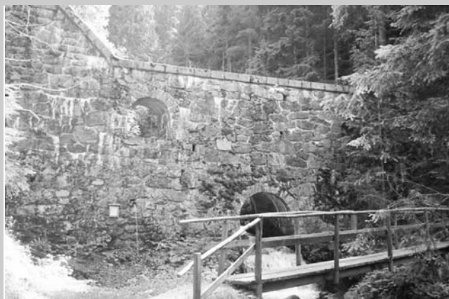
Untere Geschiebesperre oberhalb des Ságlplätzes Foto: wr
