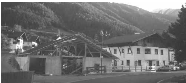
Der Rohbau des neuen Laufstalles
