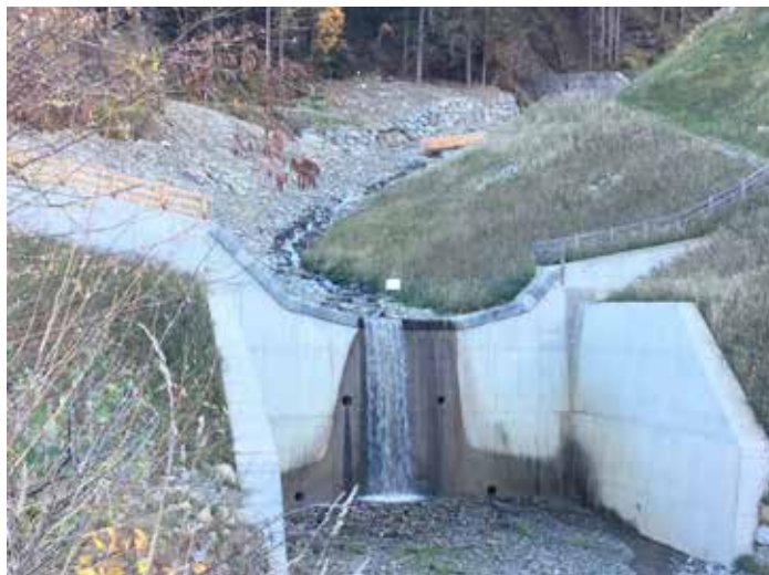
Die Baumaßnahmen der Wildbachverbauung in Oberängern sind jetzt abgeschlossen
