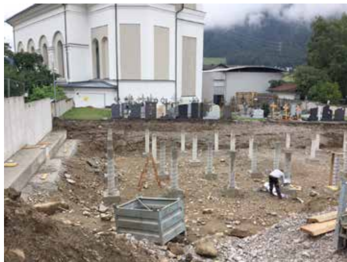
Das Erdreich wurde großräumig ausgetauscht.
