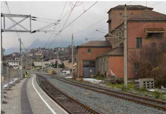
Noch wird beim Bahnhof mit Hochdruck gearbeitet. Gut Ding braucht eben Weile.
