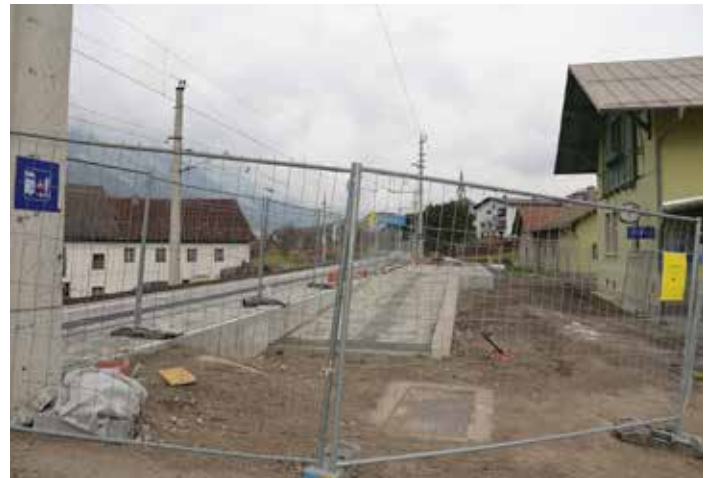
Noch ist der barrierefreie Bahnsteig 1 in Arbeit.
