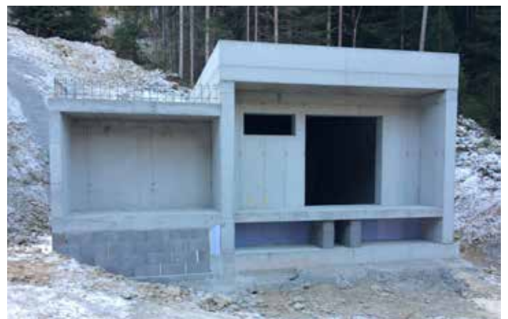
Das Krafthaus oberhalb des Hochbehälters Oberängern Foto: Gstrein & Partner
