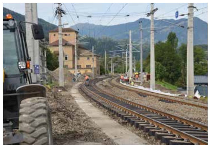
Ein Bild vom Baustart im August. Seither wurde von den Bau-trupps harte Arbeit geleistet.
