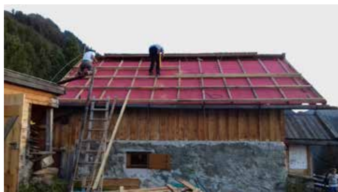
Aufwendige Renovierung des Daches.
