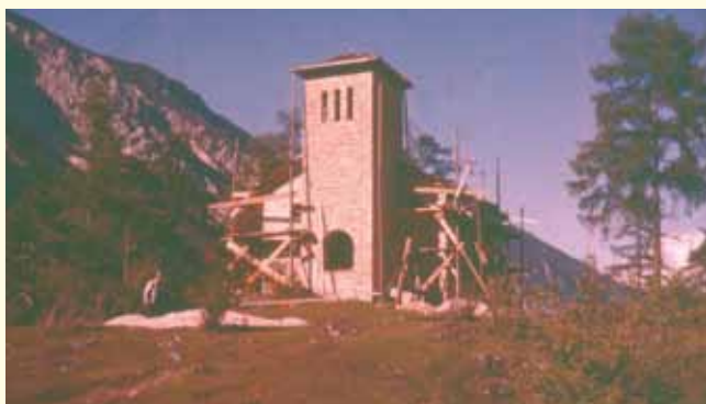
Bruder Klaus Kapelle im Rohbau um 1959
