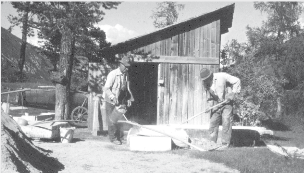
Die Brüder "k.k." Anton und Johann Köll beim Kalklößen für den Bau der Bruder Klaus Kapelle am Burschl
