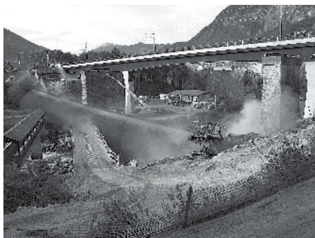
In mehreren Phasen wurde die alte Eisenbahnbrücke punktgenau an die vorgesehene Stelle zu Boden gebracht. Foto: ÖBB
