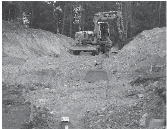
Weit fortgeschritten ist bereits die Erschließung des Steares´n Ruan, wo 10 neue Bauplätze für Einfamilienhäuser entstehen. Foto:
