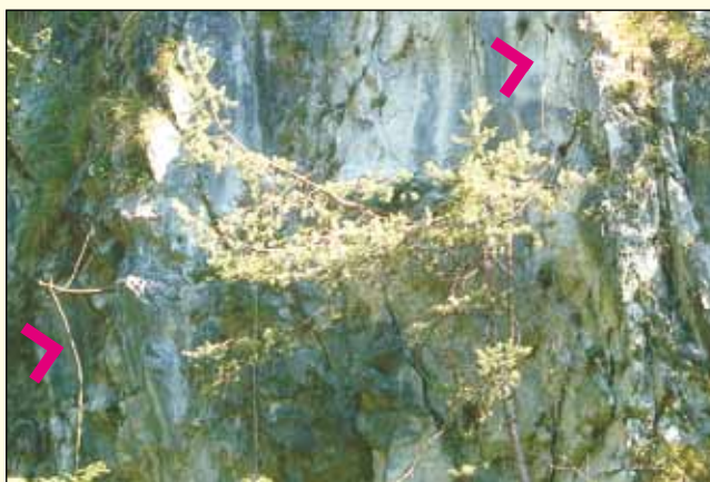
Metallhaken am Felsen (siehe Pfeile) als Halterung für die Holzrinne
