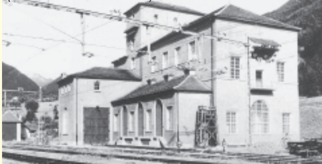
Das Unterwerk, erbaut 1925, diente als Umspannwerk (110.000 Volt auf 15.000 Volt). Foto: Chronik (1927)
