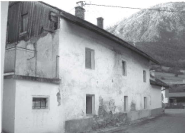
Im Frühjahr 2010 wird das baufällige „Béibl-Haus“ im Weiler Roppen abgerissen. Foto: gem
