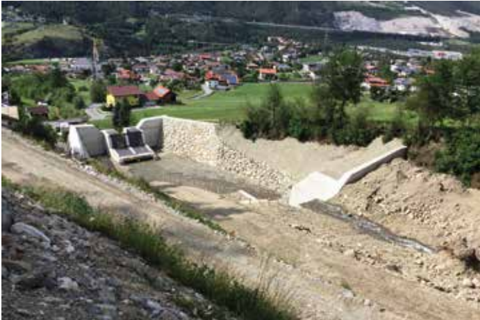
Das ausgeräumte Auffangbecken.
