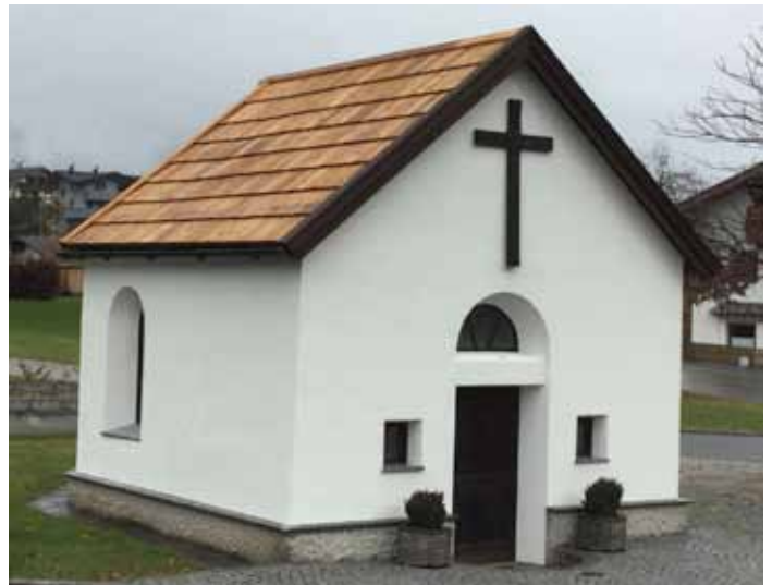
Das Dach der „Fatimakapelle“ wurde im Herbst neu gedeckt und bei dieser Gelegenheit auch gleich die ganze Fassade neu gemalt.
