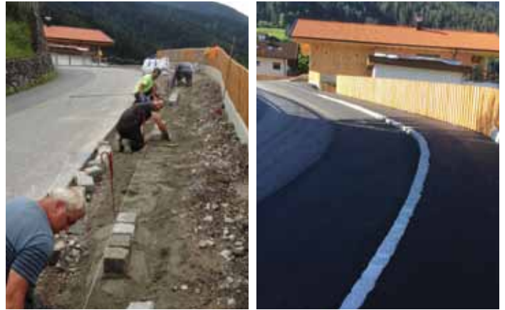
Rechtzeitig zur Kirchtagsprozession haben unsere Bauhofmitarbeiter die Randsteine verlegt, den Zaun montiert usw. sodass anschließend der gesamte Bereich asphaltiert werden konnte. Es ist eine sehr gelungene Arbeit und für die Fußgänger ist der zusätzliche Gehsteig eine Bereicherung.
