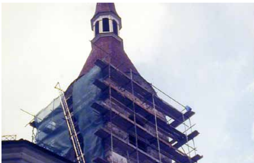
Sanierung des Kirchturmes. Der gesamte Fassadenputz der Kirche musste zuerst händisch weggeschramt werden.
