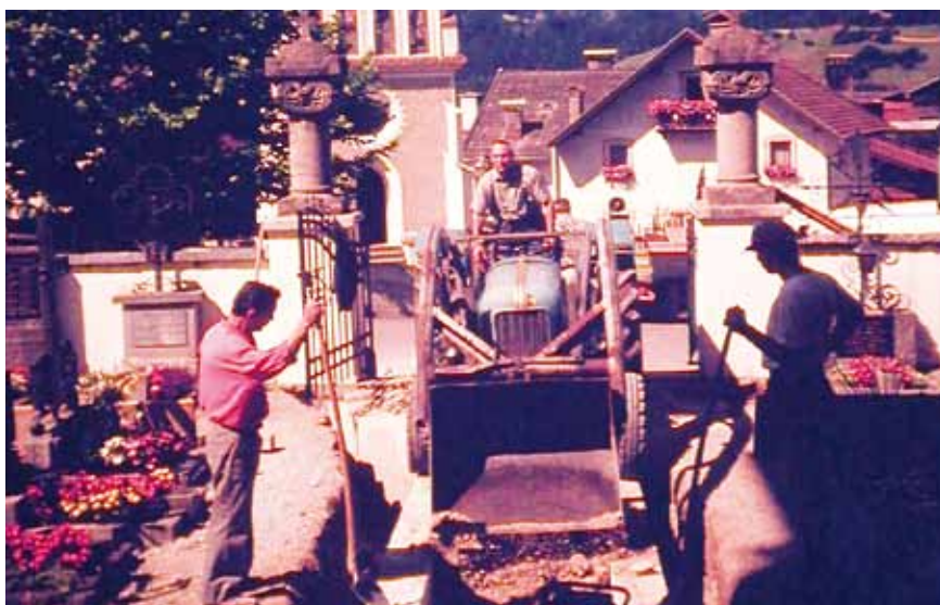
Fundamentierung und Neugestaltung des Eingangsbereiches. Schwere Geräte waren vor und in der Kirche gefordert.
