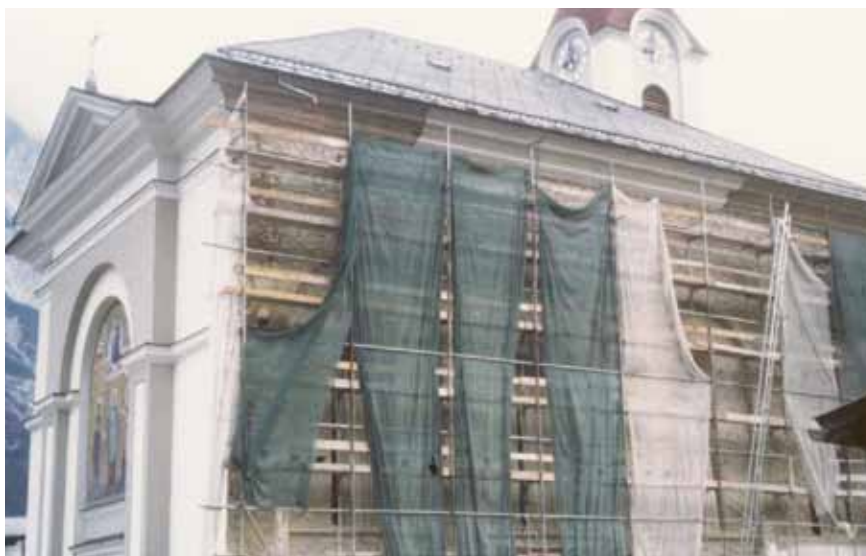
Sanierung der Südseite 1989
