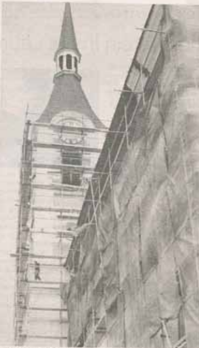
Kommende Woche ist die Fassadenrestaurierung am Roppener Kirchturm abgeschlossen, das Gerüst wird dann entfernt.
