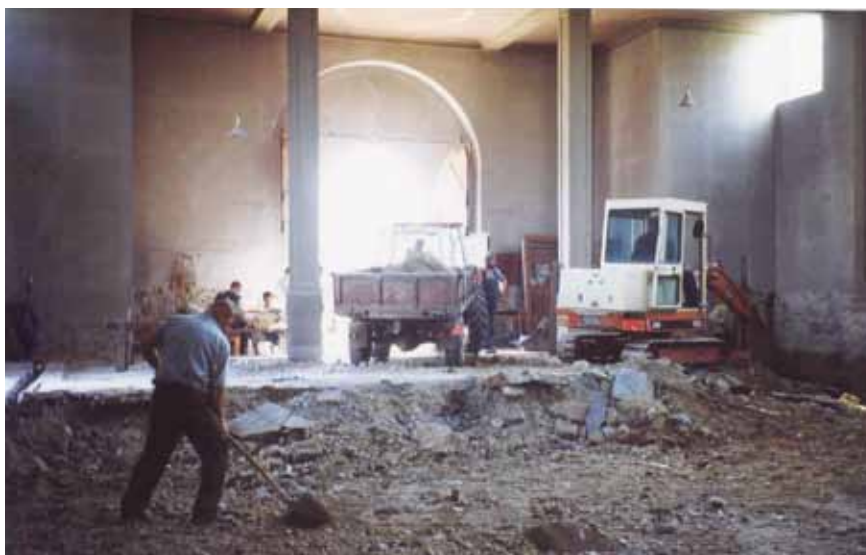
Fundamentaushub (1 m) 1993/94
