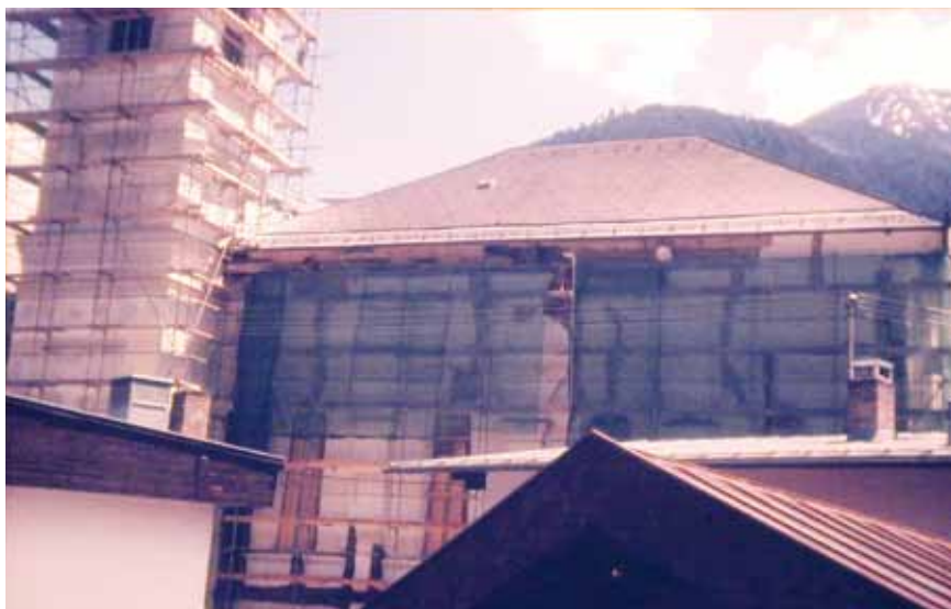
Sanierung der Nordseite
