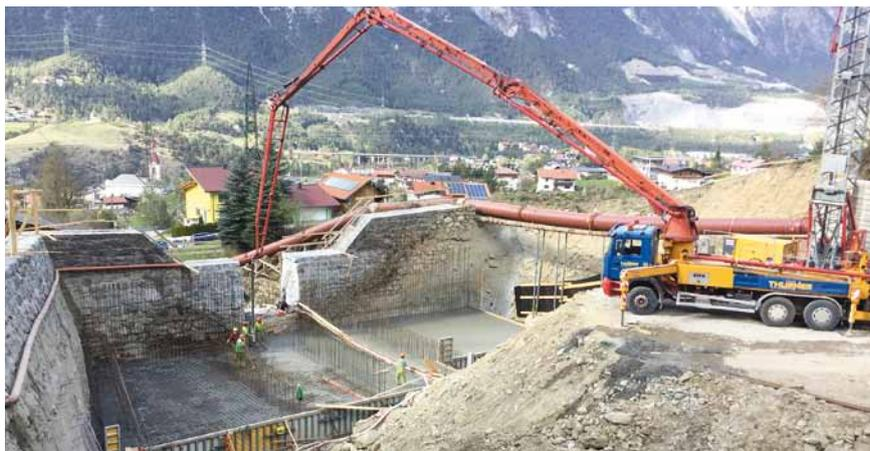
Bei der unteren Sperre werden an die 1000 qm Beton verbaut. Foto: Günter Neururer
